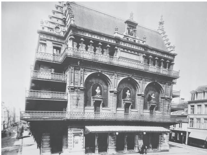
De schouwburgconstructie van de KVS van architect Jan Baes was in 1887 erg vooruitstrevend. Via de vier brede balkons aan de zijgevels konden de toeschouwers in geval van nood het gebouw snel verlaten. Vooraan boven de ingang pronkten borstbeelden van Willem Ogier, Joost van den Vondel en Pieter Langendijk. (Foto Letterenhuis, Antwerpen)
