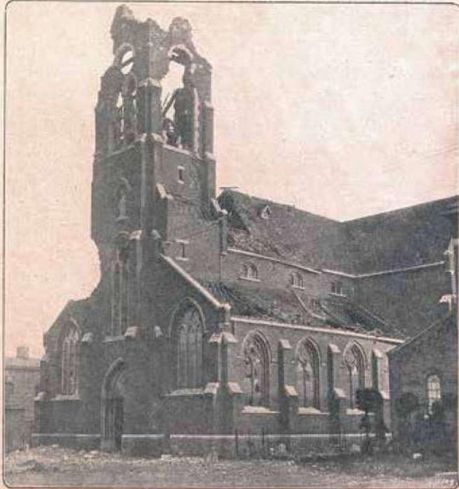
De kerk met toren, door het Duitsche granaatvuur vernield aan den weg naar het fort Lencle hyl Lijk; dit bouwwerk werd onder vuur genomen, omdat er zich een Belgische Berdan-uitkijkpost in bevond, die de uitwerking van het Belgische geschut moest nagaan.
